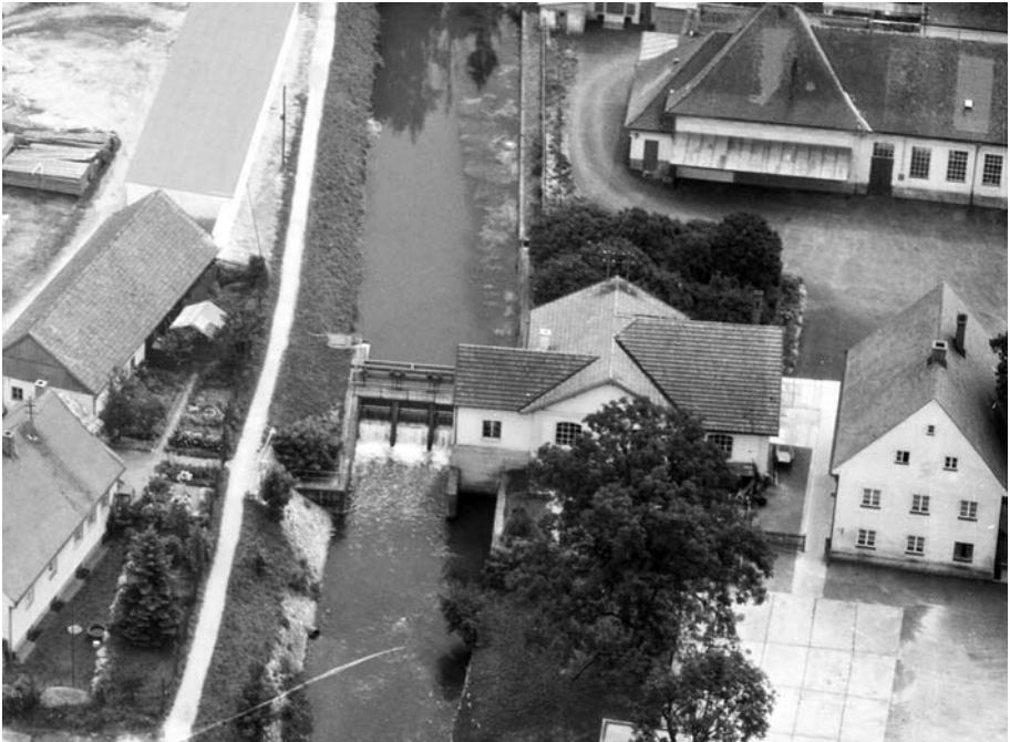
Blick auf das Wasserwerk mit Pumphaus und Turbinenanlage am Standort der historischen Arlmühle, dahinter ist ein Teil der Schlachthofanlage zu erkennen (1957)
