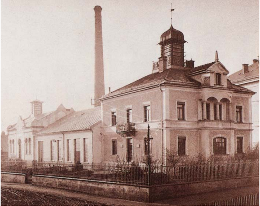
Die Keimzelle der Stromversorgung in Pfaffenhofen an der Schulstraße (ca. 1909)
