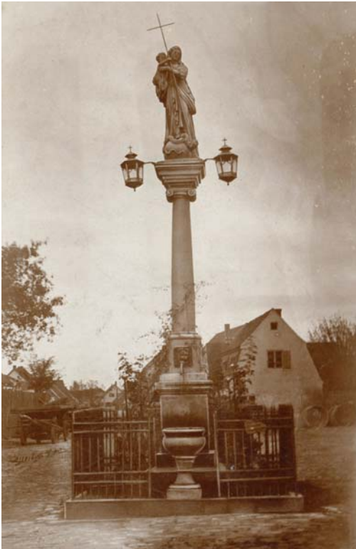
Die Versetzung der Mariensäule war Teil eines Verkehrsprojekts zur Umgestaltung der Frauen- und Türltorstraße.
