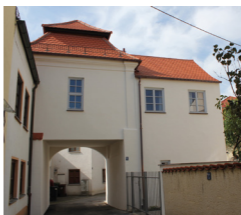
Der sanierte Flaschthurm
