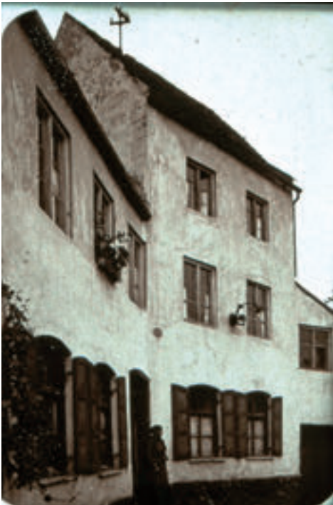
Blick auf den Folterturm nach dem Mitte des 19. Jahrhunderts erfolgten Umbau (um 1900).
